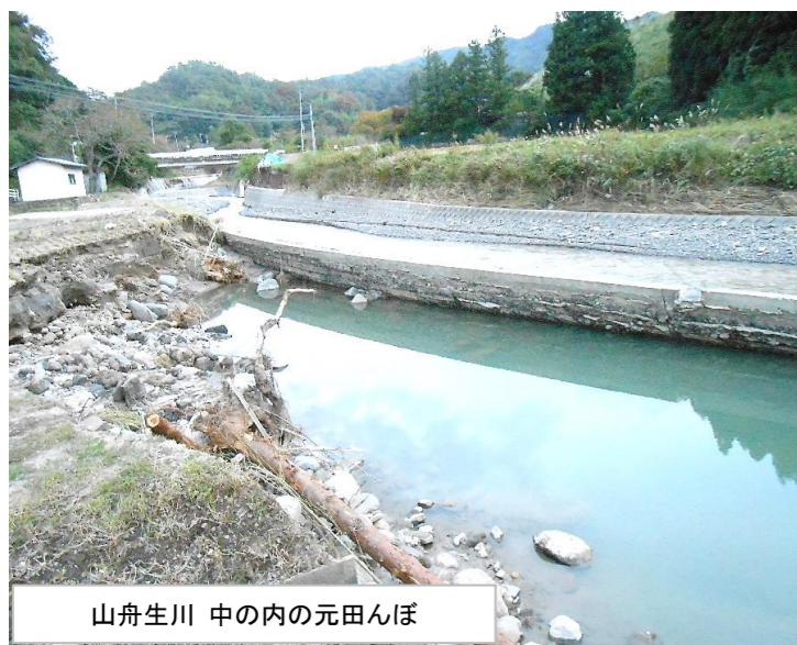
山舟生川.修復した護岸も崩壊・小手内地区
