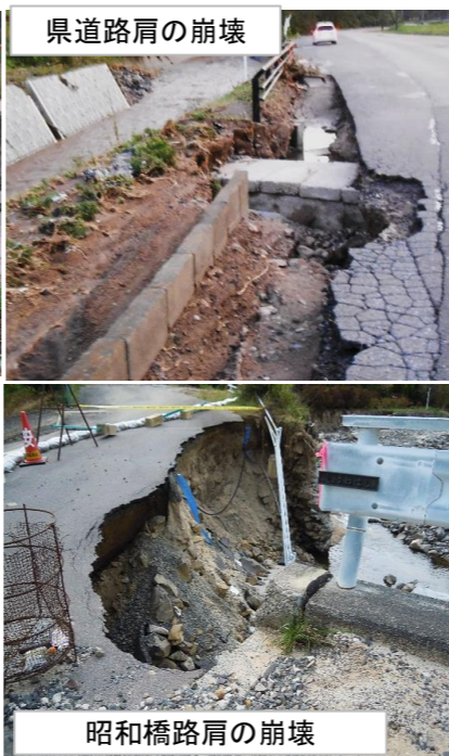
県道101号鹿野新田付近
